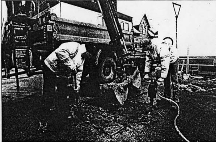
Stadtwerke-Einsatz, um gebrochene Rohrleitungen der Trinkwasserversorgung zu reparieren.
